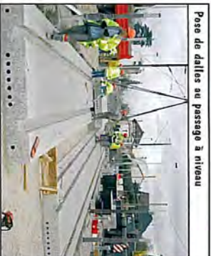
Montage d'un passage à niveau (8 dalles)
