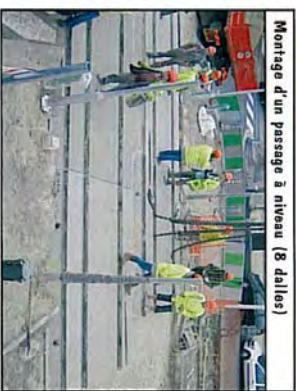
Des éléments de 16 tonnes posés au millimètre
