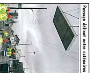
Pose de dalles au passage à niveau
